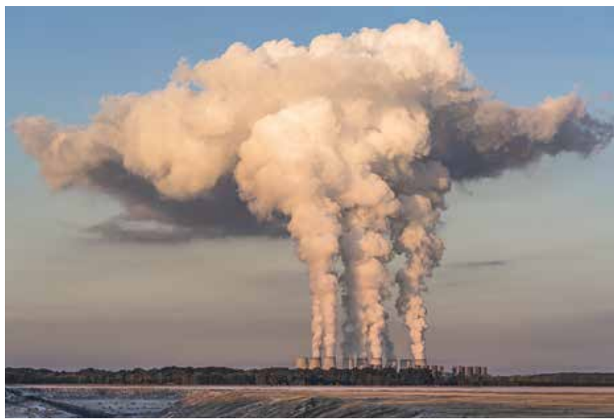
La centrale elettrica di Janschwalde in Germania
